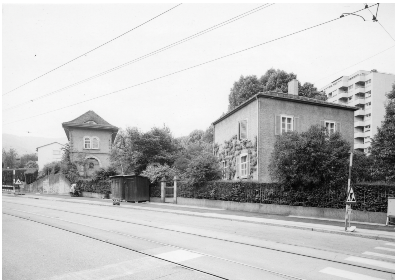
Abb. 34: Ehemaliges Wärterhaus mit Schieber- bzw. Pumpenhaus Reservoir «Albishof» 1980 (Quelle: BAZ 145249)
