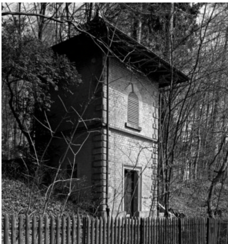
Abb. 19: Schieberhaus Reservoir «Orelli», 1896 (Quelle: BAZ_013760)
