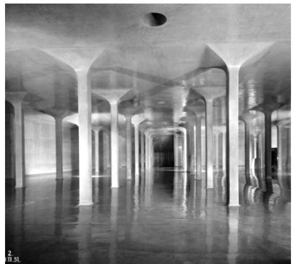
Abb. 16: Reservoir «Rosengarten» 1940 (?) betonierte, flache Decke ruht auf Pilzstützen (Quelle: BAZ_031065)
