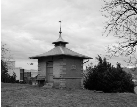
Abb. 17: Schieberhaus Reservoir «Schmelzberg», 1871 (Quelle: BAZ_013909)
