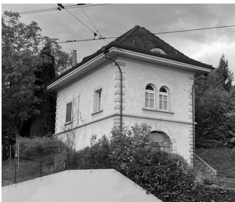
Abb. 21: Schieber- bzw. Pumpenhaus Reservoir «Albishof», 1896 (Foto 2023)
