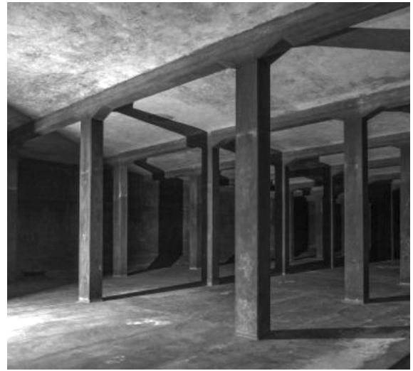
Abb. 15: Reservoir «Rosengarten» 1930, betonierte, flache Decke ruht auf Unterzügen (Quelle: BAZ_021950)
